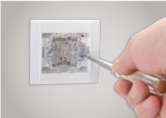
④ Tırnak vidalarını sıkarak duvara sabitleyin.
